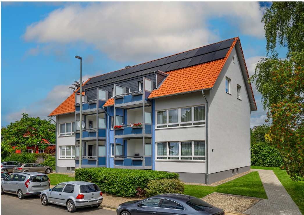
Sanierung: Elbinger Str. 2a, Wolfenbüttel
