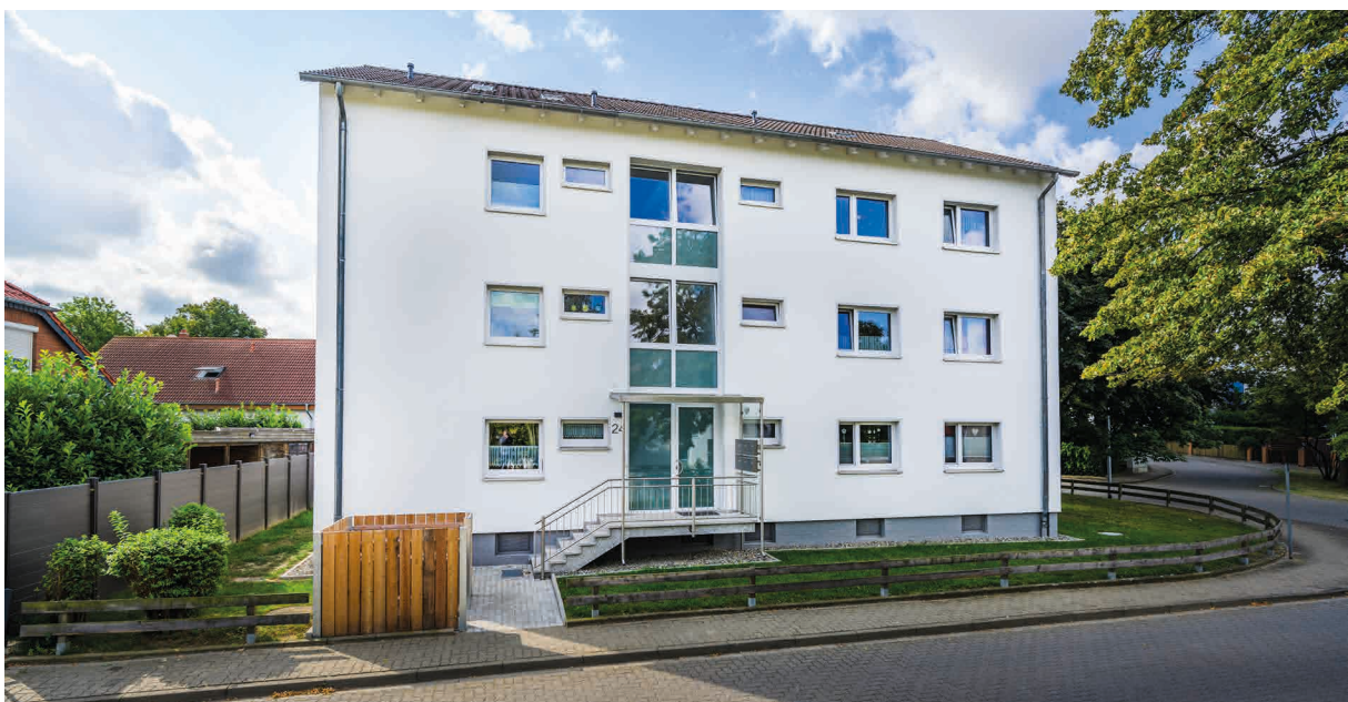
Sanierung: Am Klinkenberg, Adersheim
