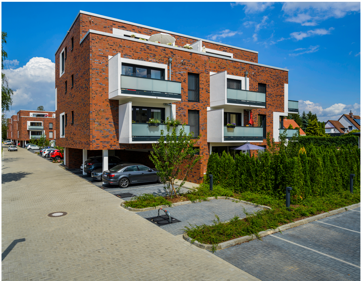
Neubau: Am Rodeland, Wolfenbüttel
