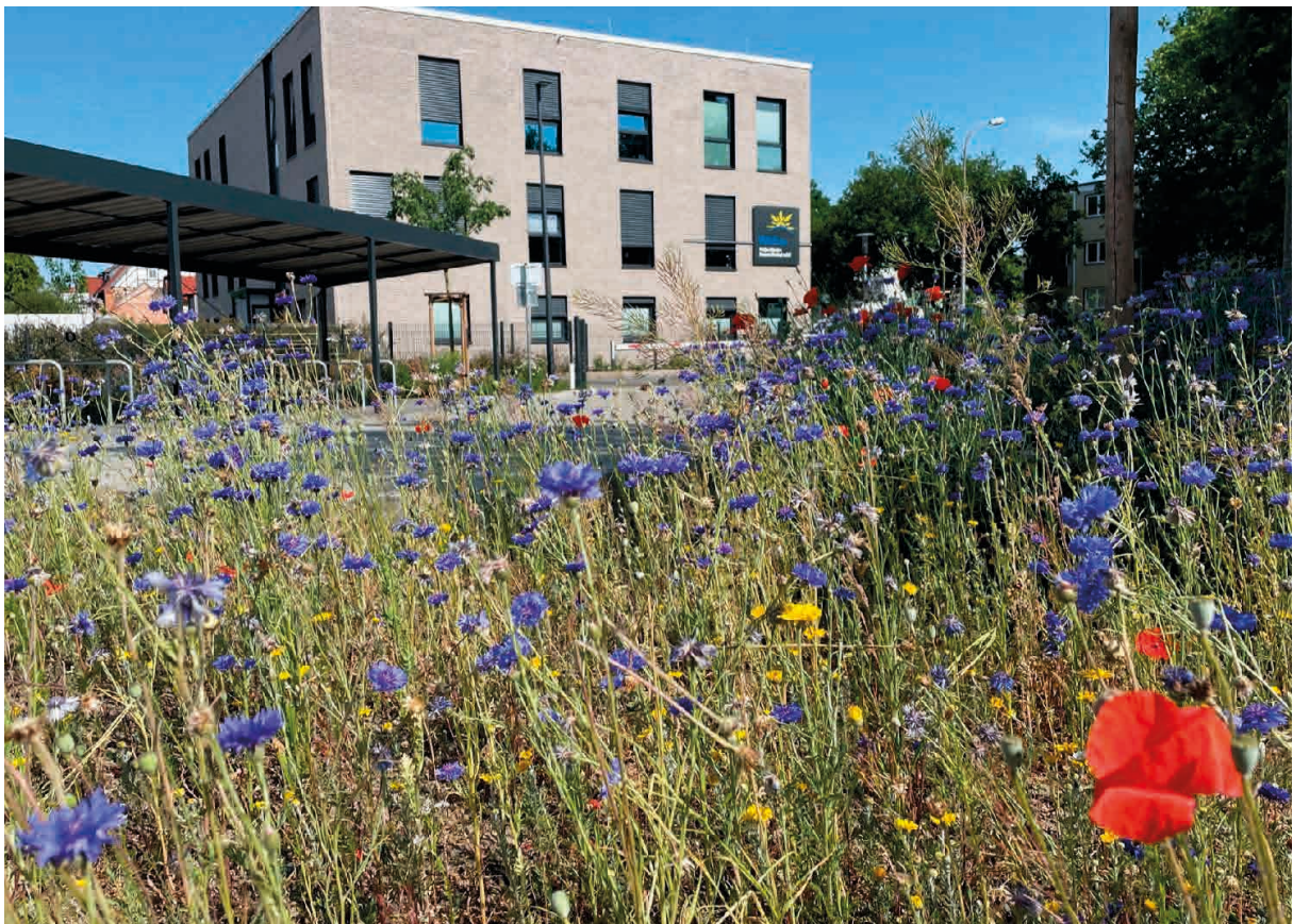
WoBau-Verwaltungsgebäude Grüner Platz 24: Blühwiese
