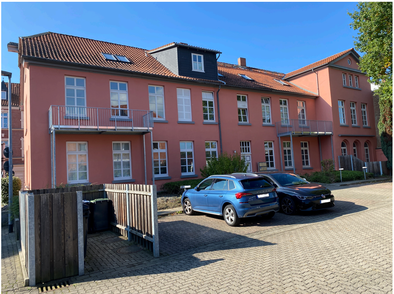
Sanierung im Denkmalschutz: Dr.-Heinrich-Jasper-Str. 6, Wolfenbüttel
