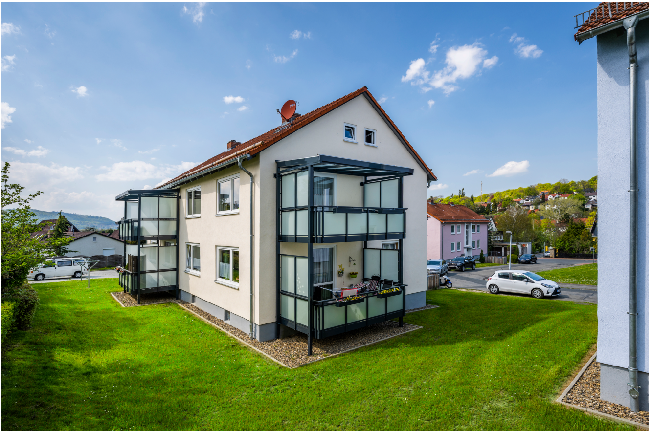
Sanierung: Finkenweg, Bad Harzburg
