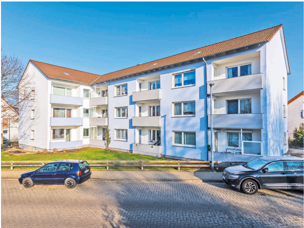
Sanierung: Westerntorstraße 24, Adersheim
