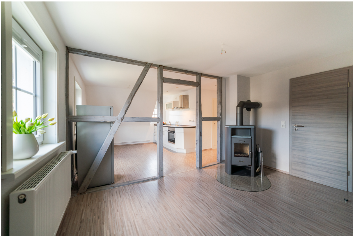
Sanierung: WZ nach Grundrissänderung, Unter den Linden, Bad Harzburg
