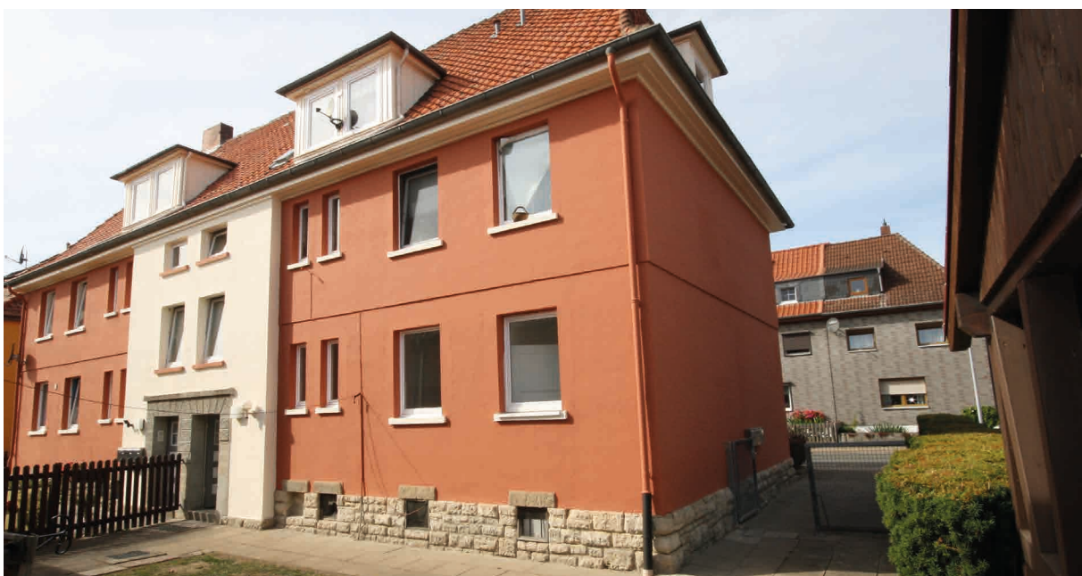
Sanierung: Elmstraße 29, Schöppenstedt
